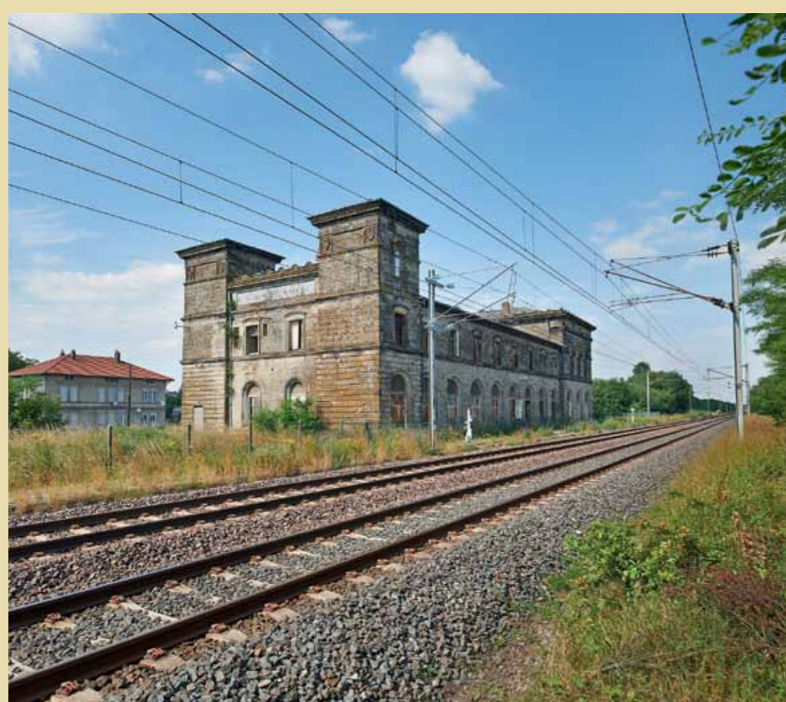
La gare depuis la voie ferrée.
